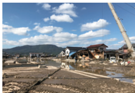
令和元年東日本台風による長野県長野市の被害の状況（撮影：中村晋一郎）
